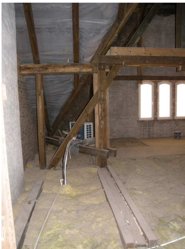
Fot 6. Wzmocnione podwaliny niezgodnie z zaleceniami ekspertyzy z listopada 2012r.
